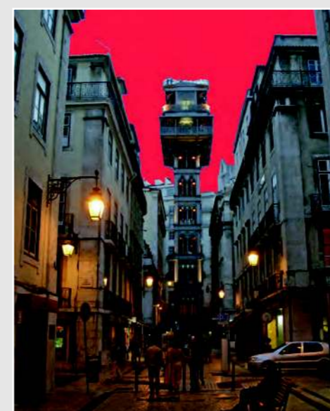
Elevator Santa Justa Lissabon
